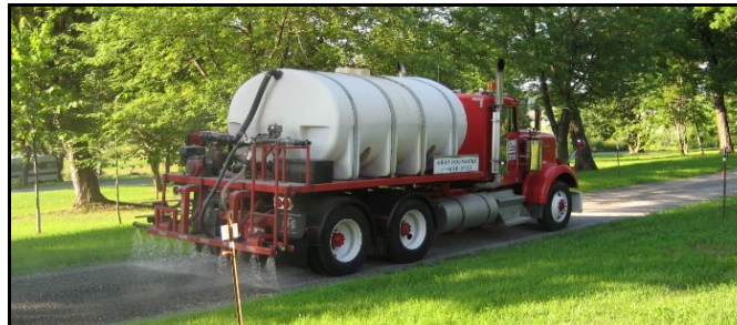
Stabilisation de route.
