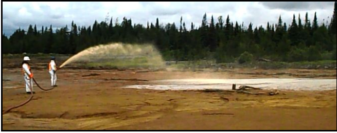
Application à la main sur un parc de résidus miniers.
